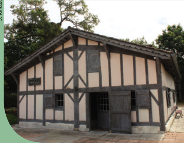
Maison natale de Saint Vincent-de-Paul sur le lieu de la formation
